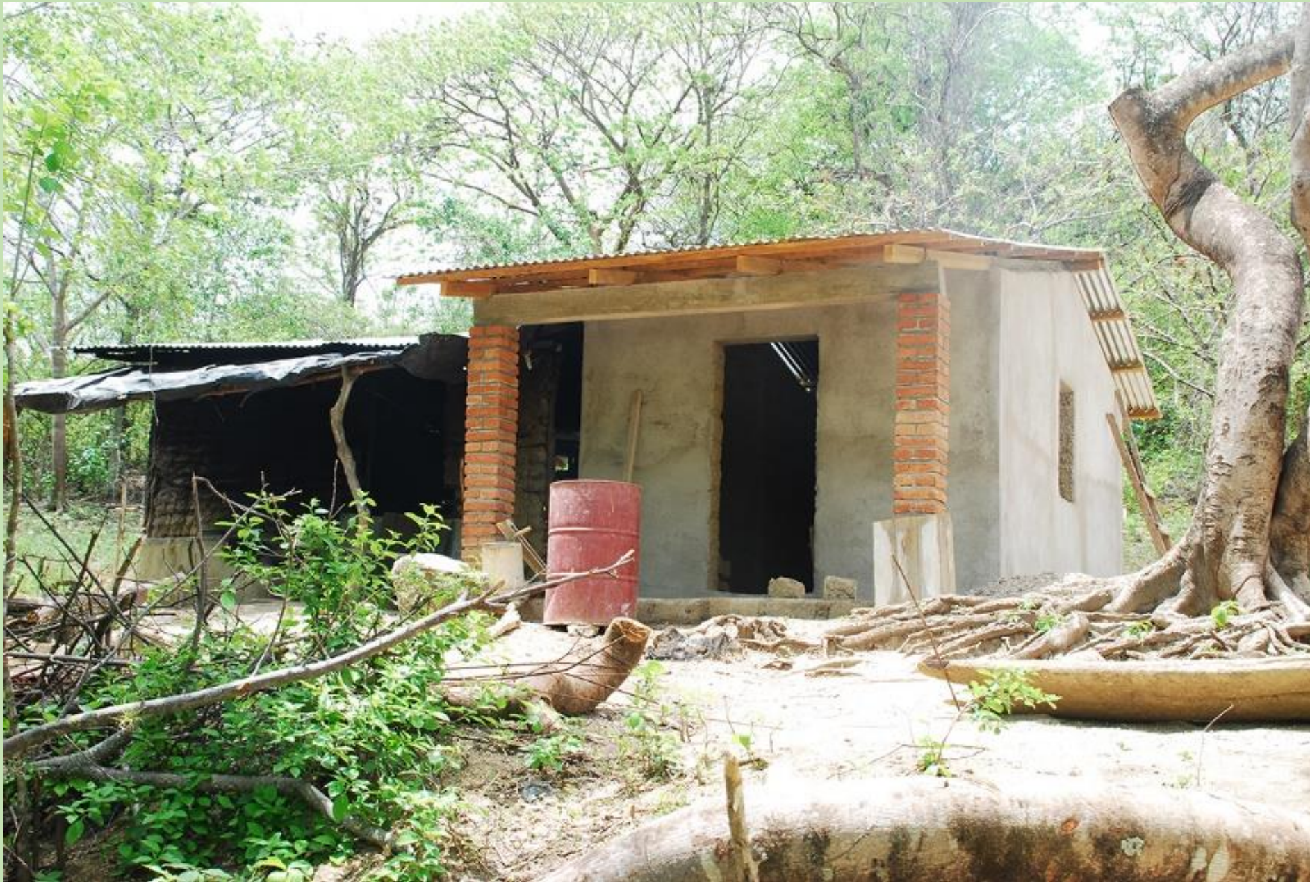
Cocina vieja y construcción de nueva al lado
